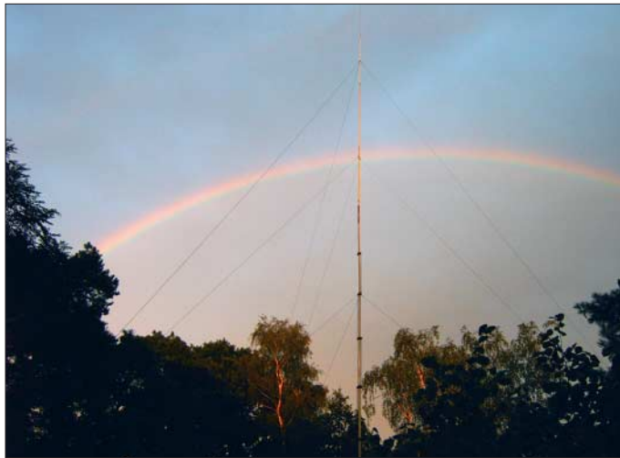
Bild 1: Abgespannte Dreiband-Groundplane vor dem märkischen Himmel
